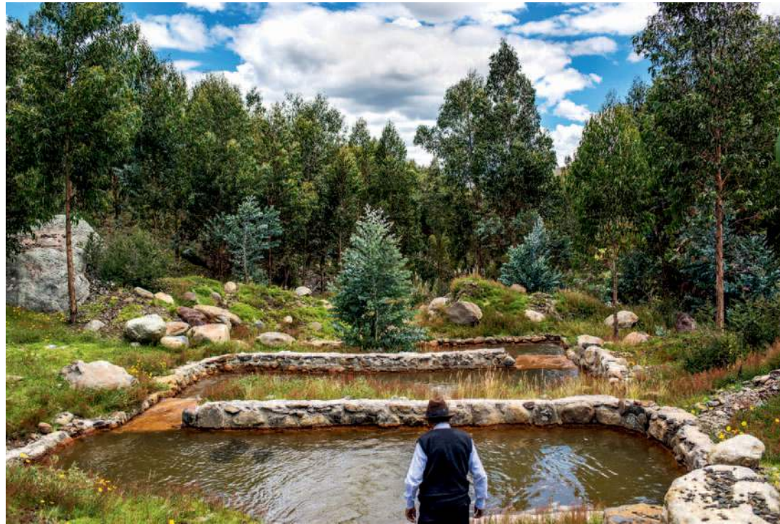
COLADERA NATURAL. Para filtrar los metales que contaminan el río Negro, los cuales perjudican sus tareas domésticas, los pobladores construyeron pozos de sedimentación en el canal de Chonta.
