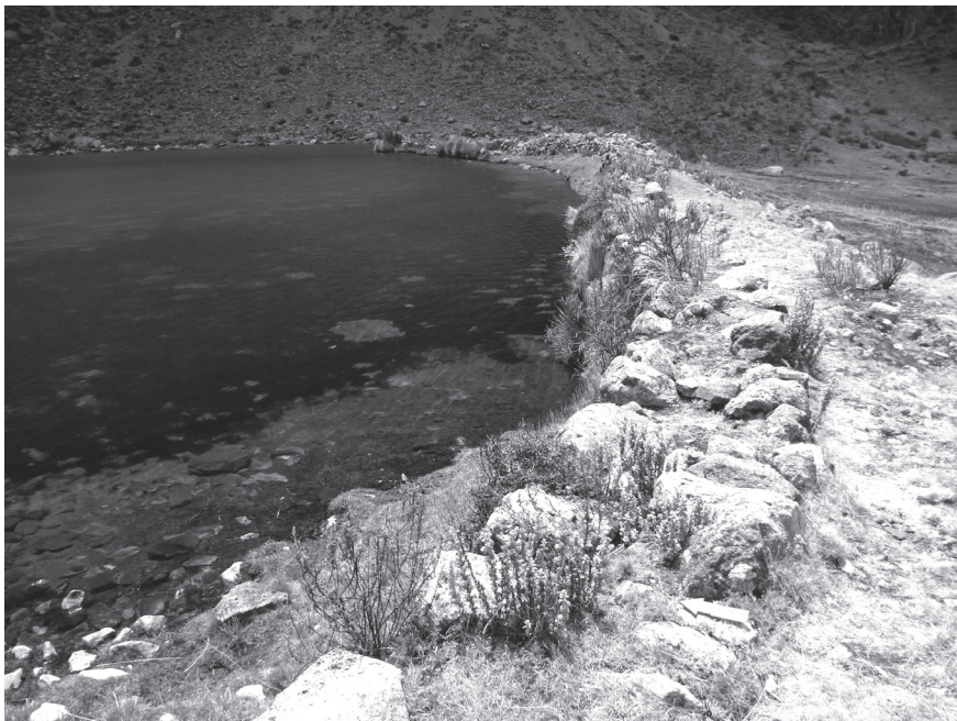
FOTO 1. SEGUNDA REPRESA DE YANACANCHA, CON MURO DE DOBLE HILADA.
