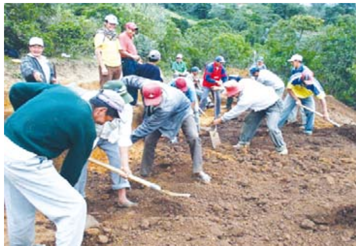
Pobladores de Totora, realizando la nivelación del terreno para las camas de repique del vivero.
